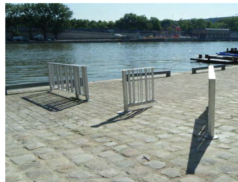
Prototype clôtures de 1m30 de hauteur Ports de Paris. Ce type de clôture va être augmenté à 2m de haut.
