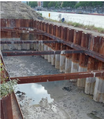
Bassins de décantation avant et après la pose des pieux dans le sol
