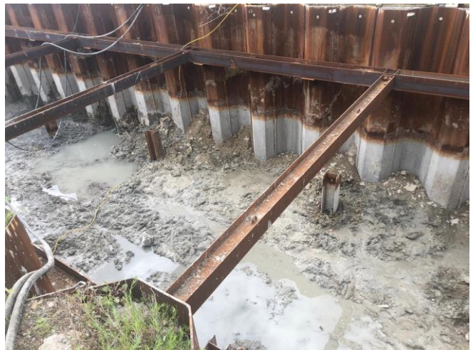
Bassins de décantation avant et après la pose des pieux dans le sol
